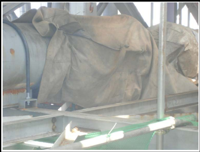
먼지 비산 방지용 DUST BAG 설치
