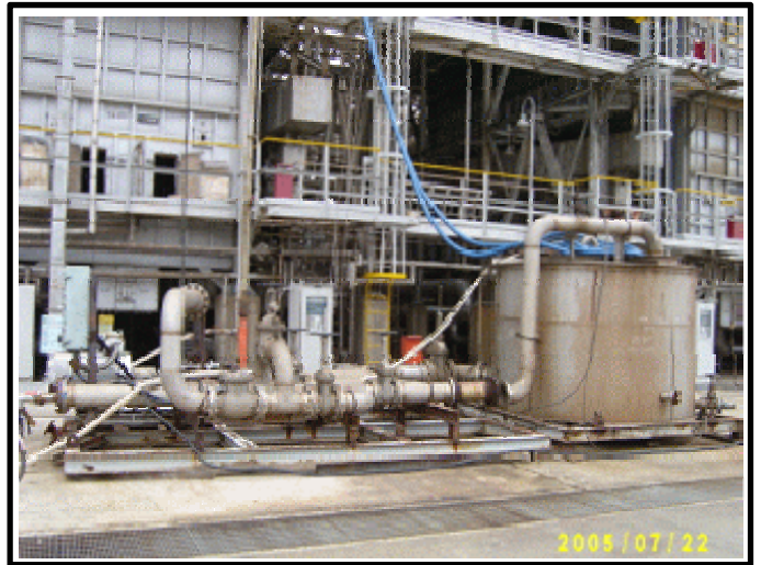
DECOKING용 PUMP 및 물탱크 설치
