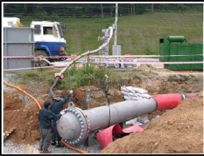
설치 된 PIG 발사관
