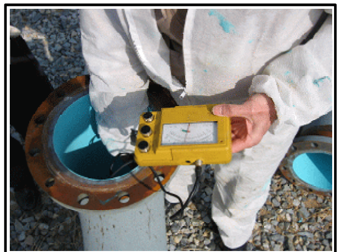
LINING 도막 두께측정
