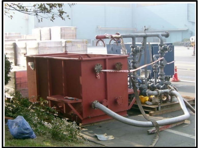
CLEANING용 PUMP 및 물탱크 설치
