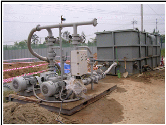
PUMP 및 물탱크 SETTING
