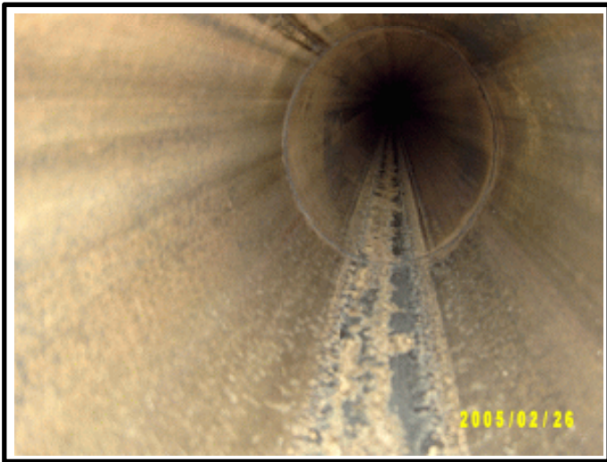
LINING 전 배관 내부
